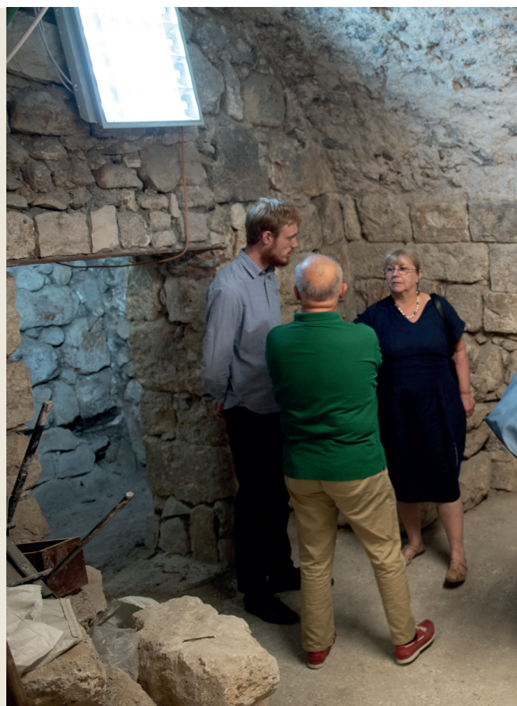
L'installation de la section historique nécessite des travaux considérables de confortement et de création d'espaces.
