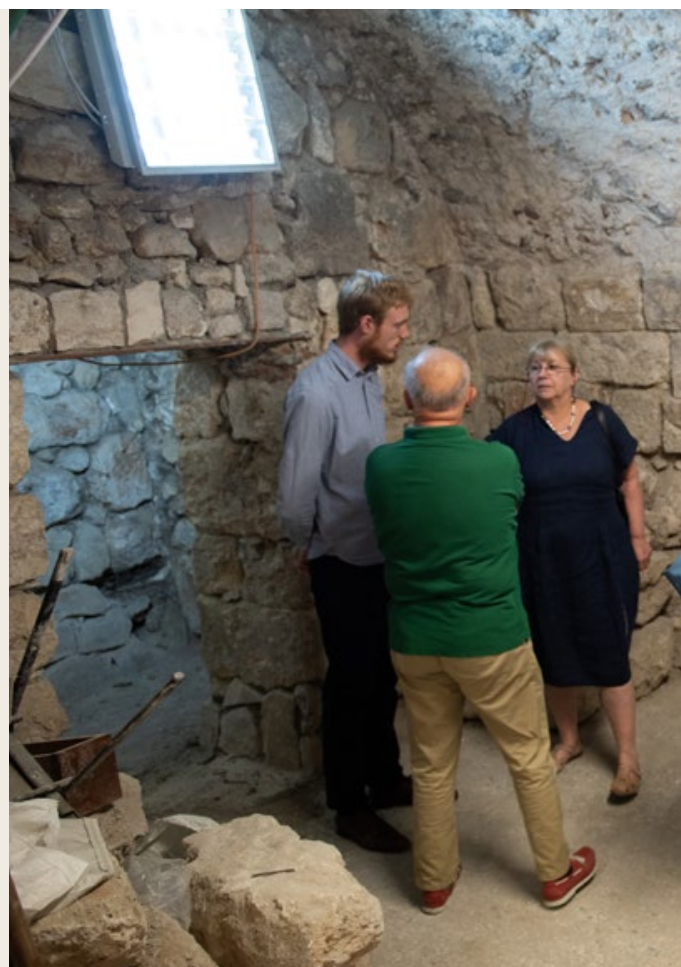
L'installation de la section historique nécessite des travaux considérables de confortement et de création d'espaces.
